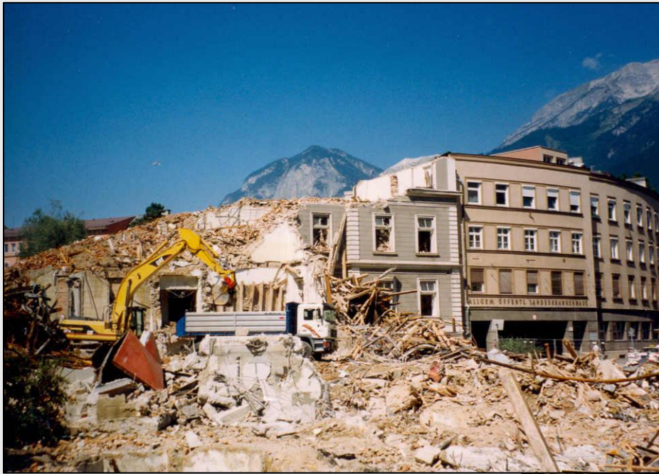
Abriss der Alten Frauenklinik 1998
